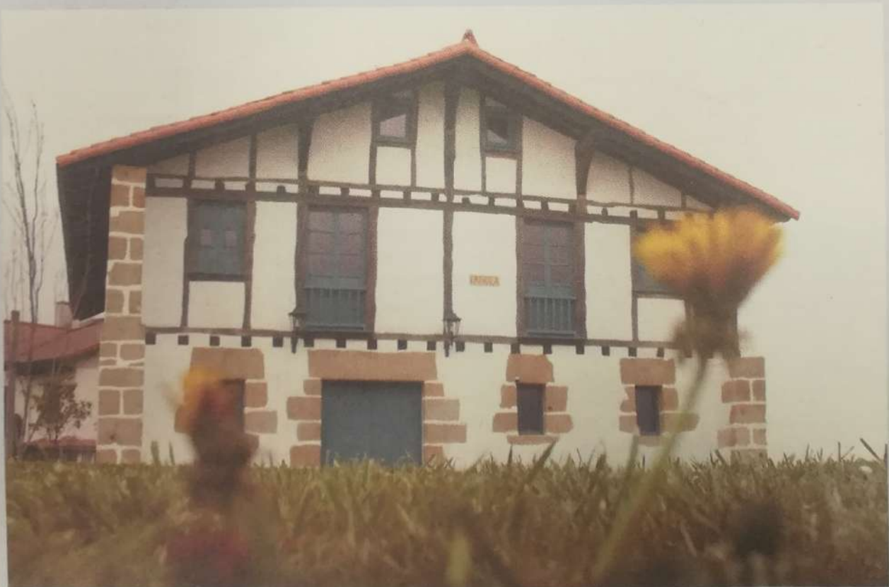
Se pretende que que al caserío Katxola acudan los escolares a aprender cómo se hace la sidra.
