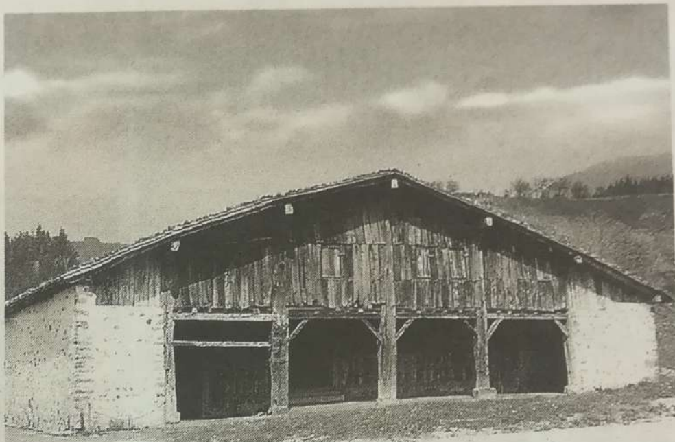
Imagen del libro que muestra el caserío tras su rehabilitación.
