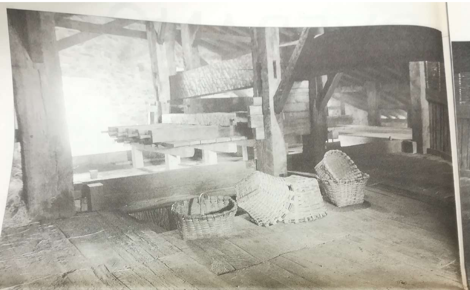
La impresionante maquinaria del lagar. La viga mide 11 metros de largo, medio de lado y pesa dos toneladas. Es el corazón del caserío Igartubeiti.
