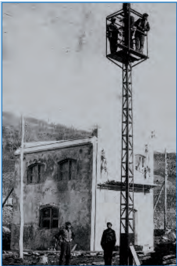
Zentral termikoa eraikitzen, 1930ean
