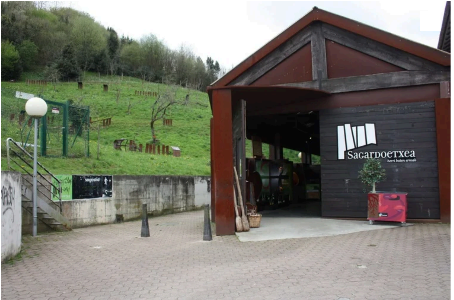
Entrada principal de Sagardotxea.
