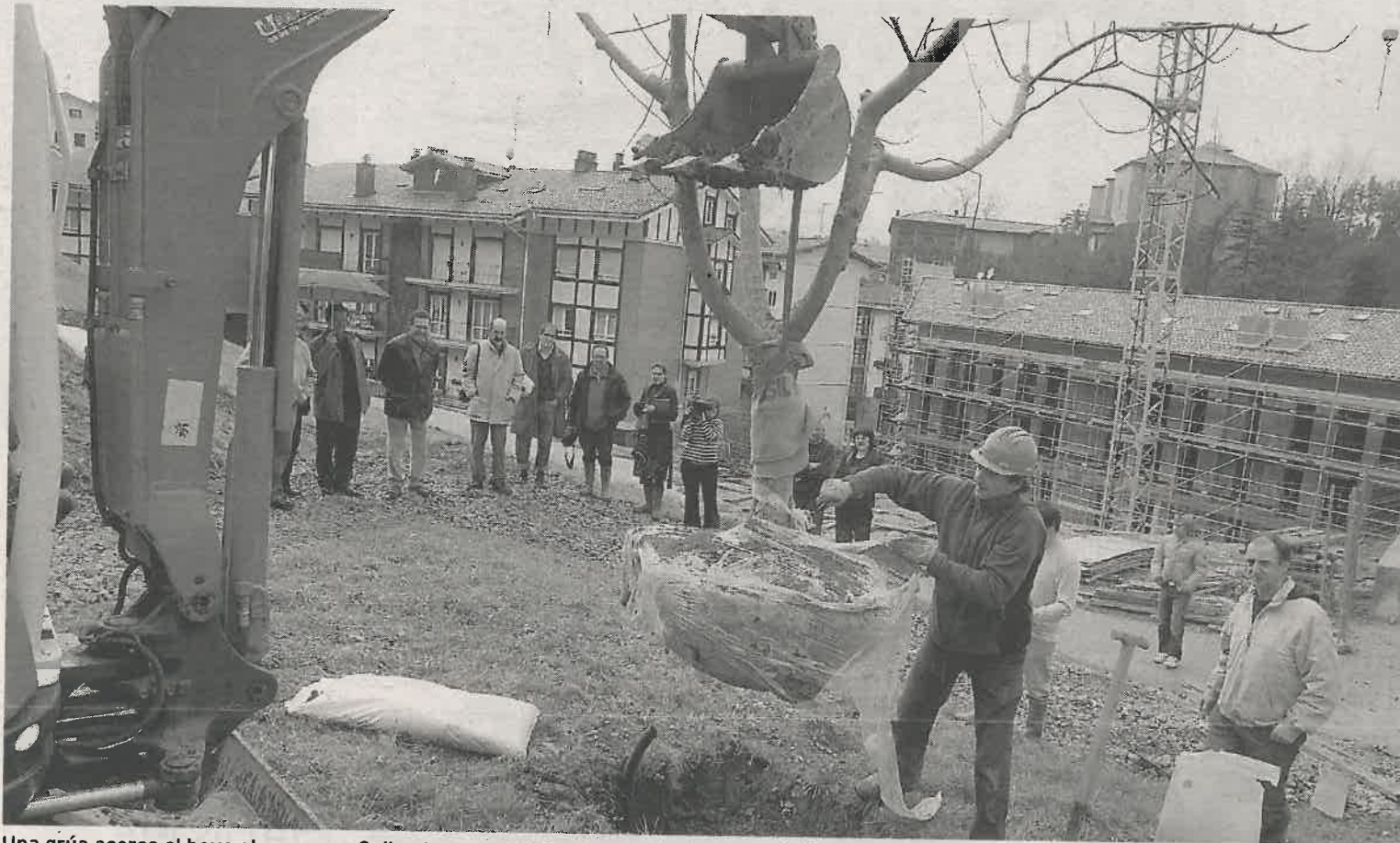
Una grúa acerca al hoyo el manzano Goikoetxea con su cepellón, en los terrenos del futuro Manzanal Pedagógico. [MICHELENA]
