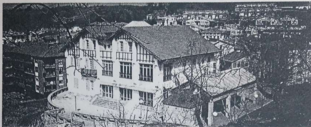
Imagen del edificio en el que se instalará la denominada Sagardo Etxea de Astigarraga. FOTO: AIMARA HERNANDO
