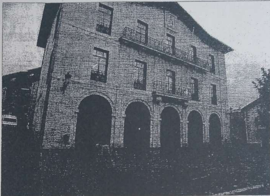
La casa consistorial de Astigarraga, construida hacia el año 1750.
