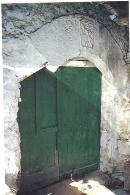
Goikoetxea baserriaren sarrera Acceso en caserío Goikoetxea
