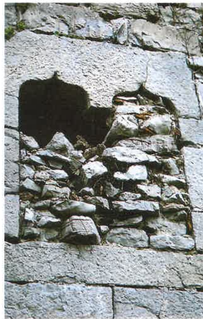
Bortanea baserriko lehiokonopialak Ventanas conopiales en caserío Bortanea
