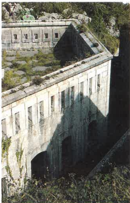
Txoritokietako gotorlekua Fuerte de Txoritokieta
