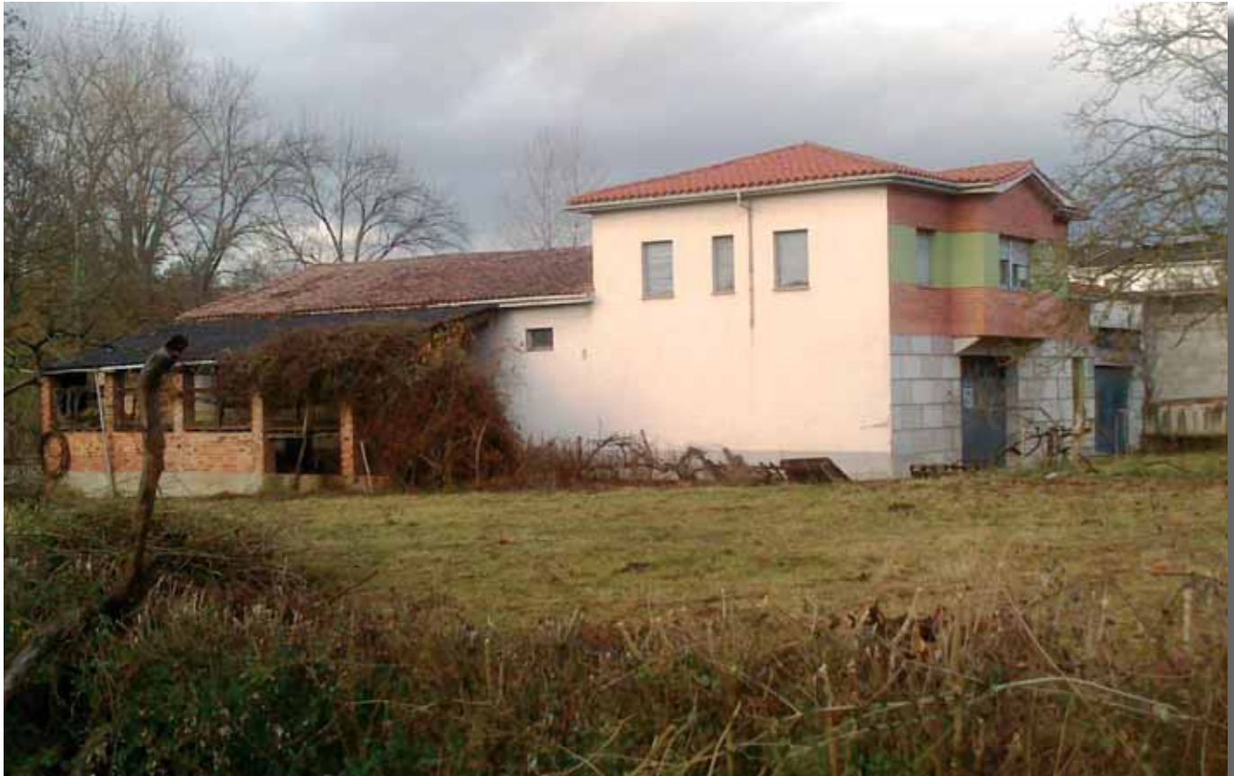
Edificiu del Llagar de Ramón Alonso
