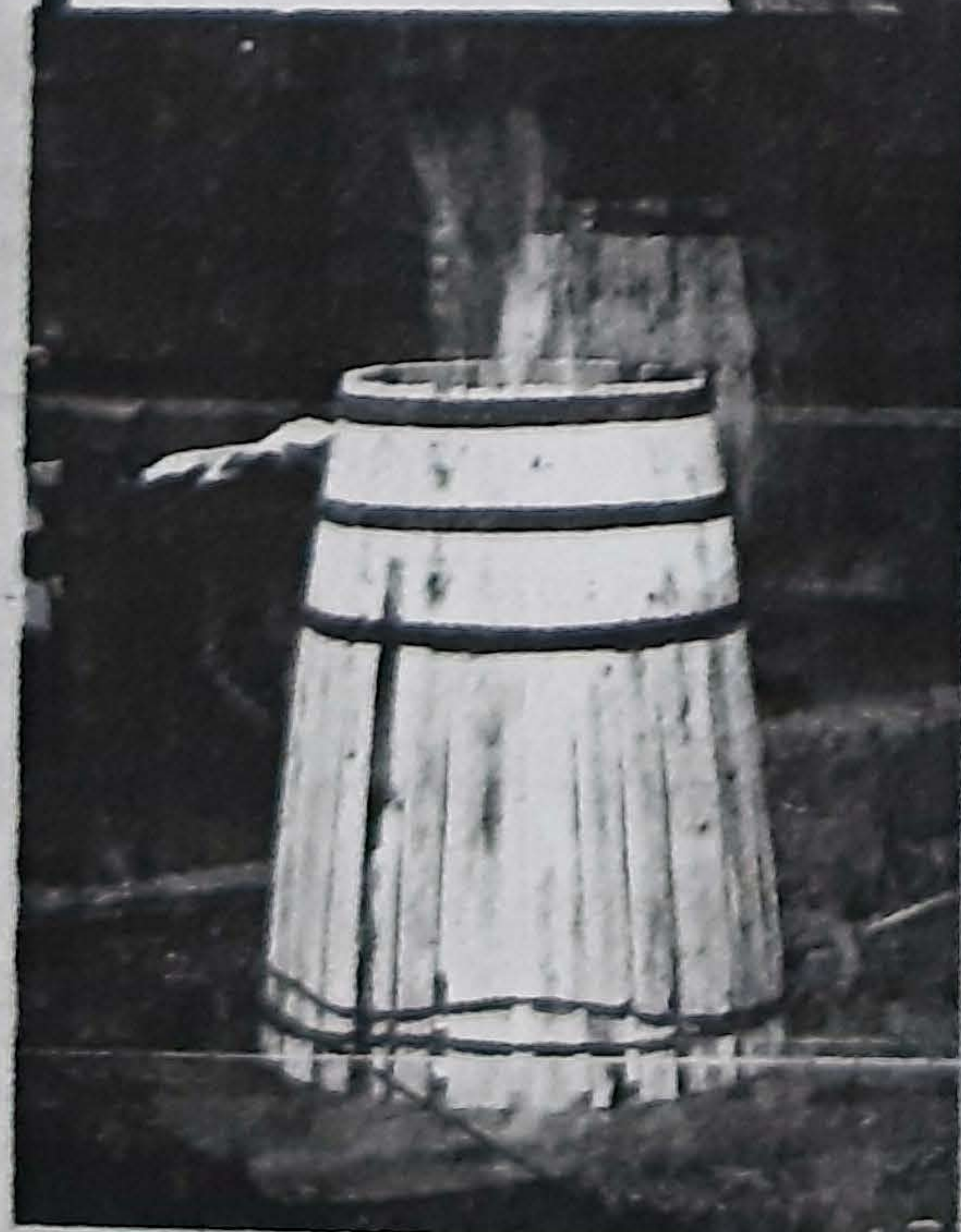
El tonel, bajo la acción del calor del fuego. En la parte inferior, la sirga con la que se tensa la madera hasta que las duelas se cierran.
