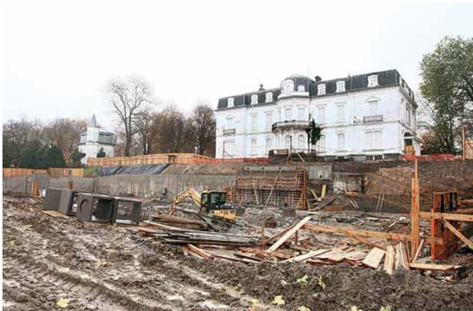
Las obras para ubicar la futura Casa de Cultura del Palacio de Aiete ya han comenzado.
