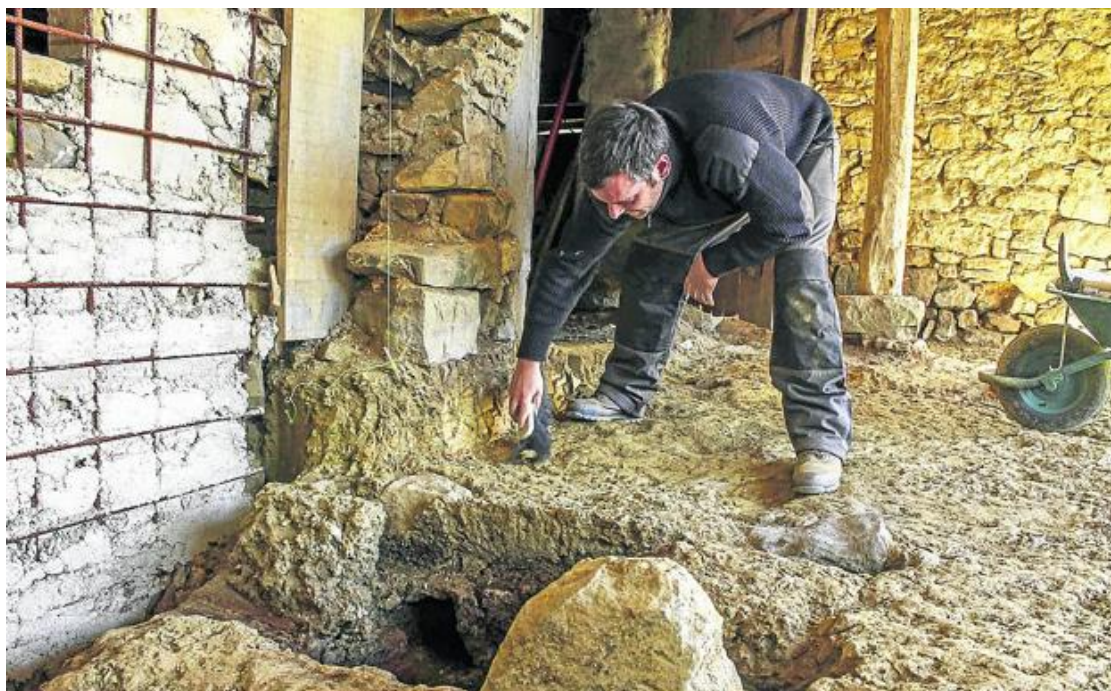
Zapata interior en la que se apoyó una de las vigas de la prensa de sidra mientras funcionó. / JOSÉ MONTES
