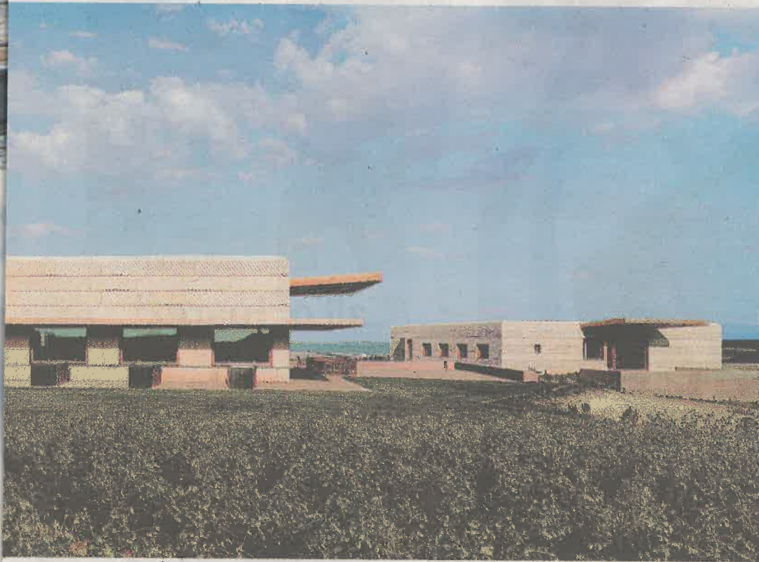
vs contrasta con las líneas modernas del edificio de la firma Juan Alcorta.
