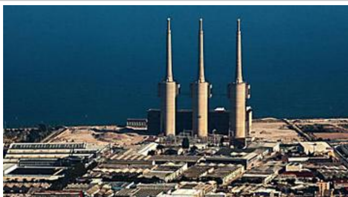
El primer esbozo para las Tres Chimeneas de Sant Adrià prevé pisos, empresas y hoteles
